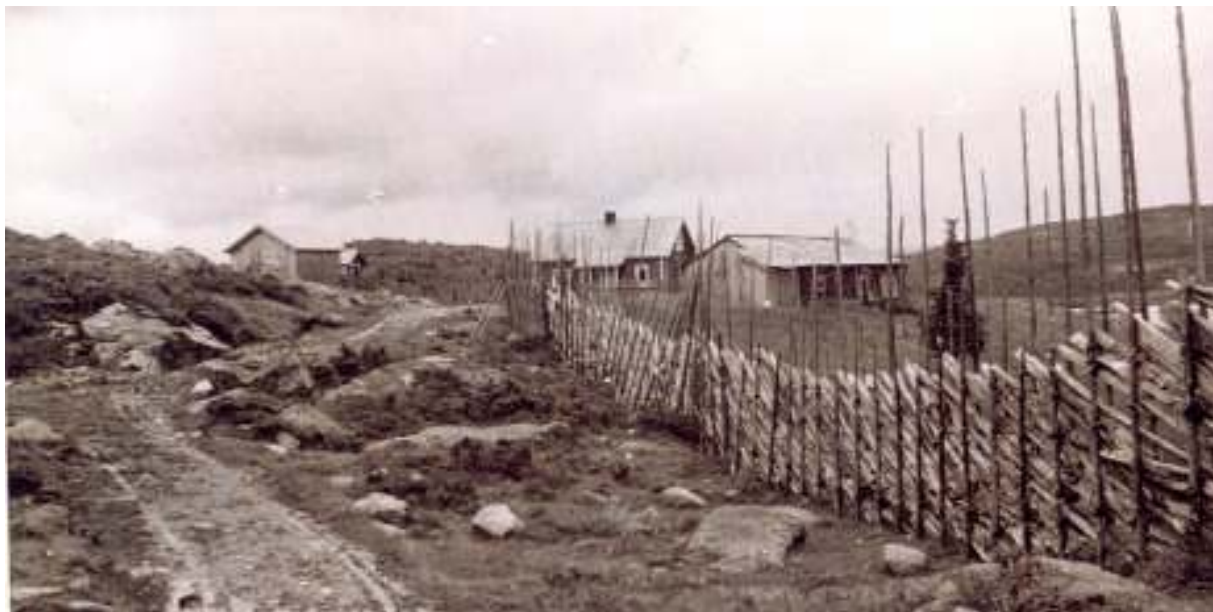
Haugen seter (sommeren 1939). Kjerreveien går ned til broen over Røysåne
